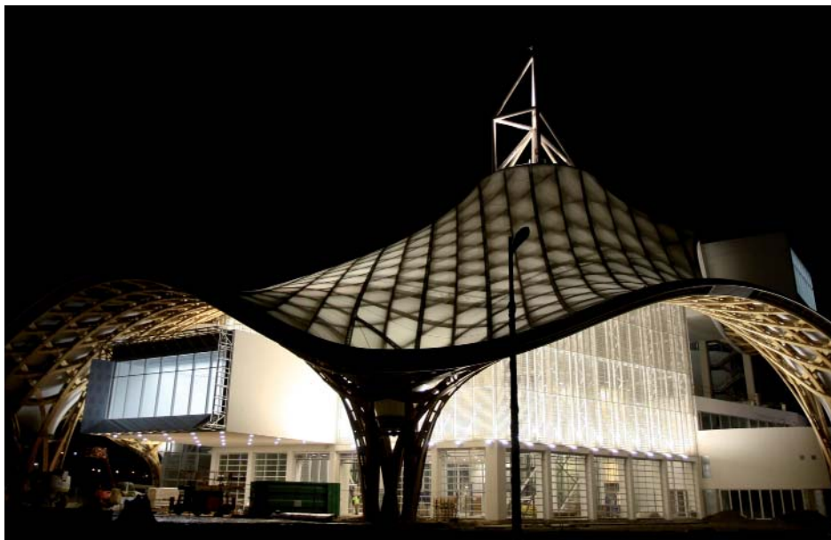
Le Centre Pompidou-Metz qui, avec son architecture signée Shigeru Ban et Jean de Gastines et ses expositions d'art moderne, vise 250.000 visiteurs par an.
