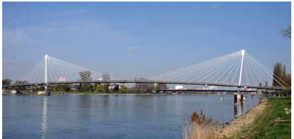
Passerelle des Deux Rives Kehl.
